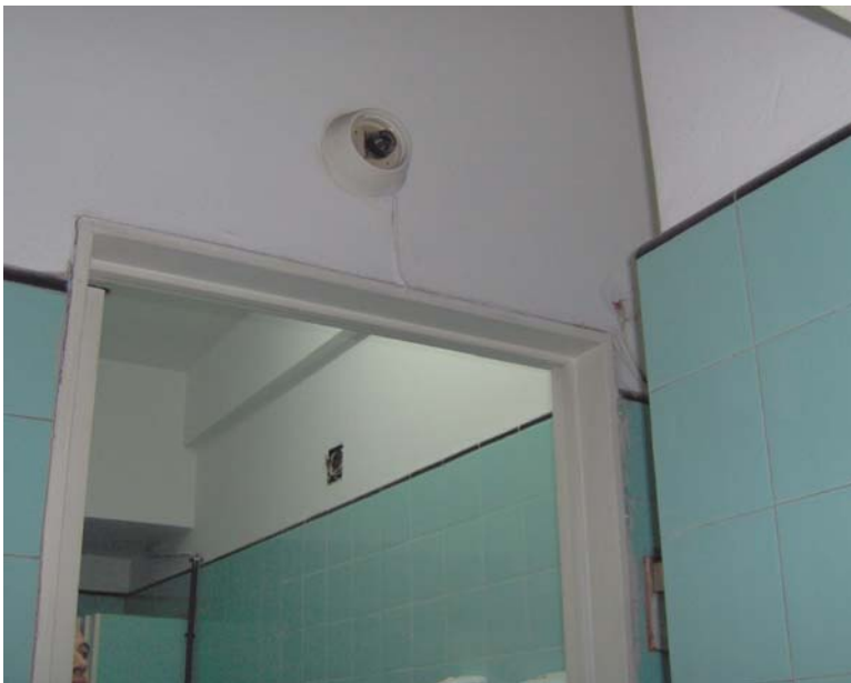
Foto N° 14 – Idem foto n° 13.
