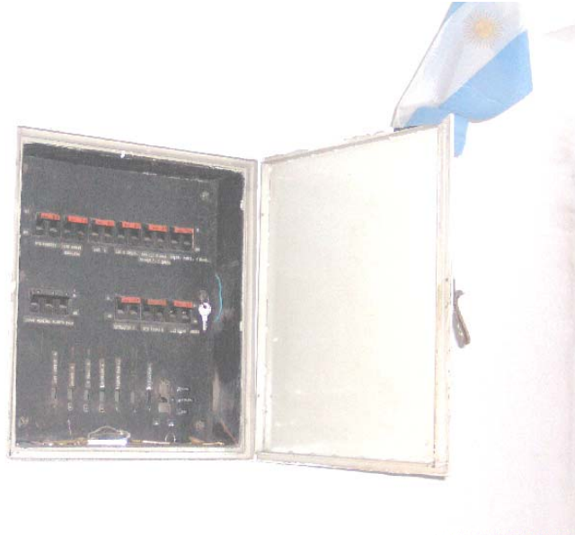
Foto N° 15 – Tablero seccional ubicado dentro de la vivienda en planta baja, en coincidencia hay otro tablero en el piso superior sin tapa exterior, ver foto N° 20.
